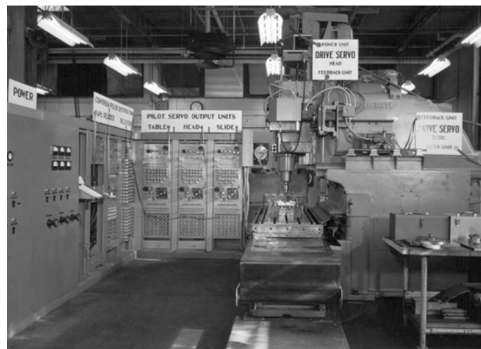
Abbildung 8: Erste numerisch gesteuerte Fräsmaschine im März 1952 am MIT 252
