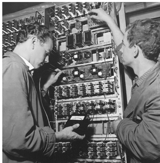
Abbildung 59: Heller-Schaltschrank mit Relaisrahmen 1461
