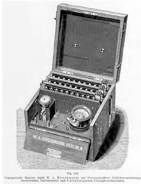
Abb. 14: Transportable Batterie mit Legende zum Instrumentarium
