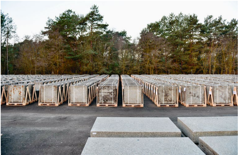
Abb. 3: Inventarisierte und gelagerte Bauteile (Granitbelag der Terrasse) der Neuen Nationalgalerie von Ludwig Mies van der Rohe
