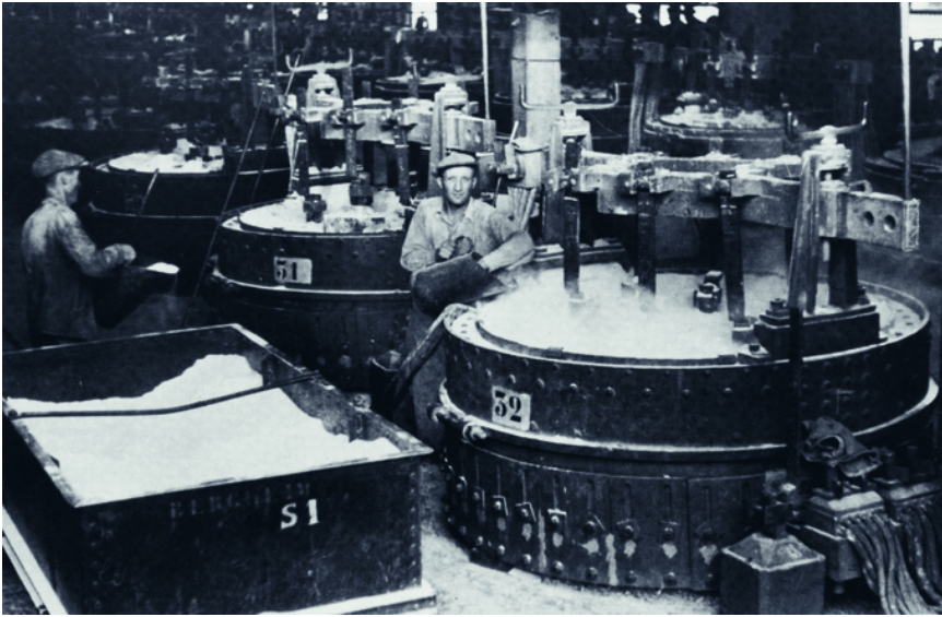
Abb. 28 Elektrolyseofen Chippis in frühen Betriebsjahren (Aluval 177, 1989, in: SWA, PA 600b G 3-5).
