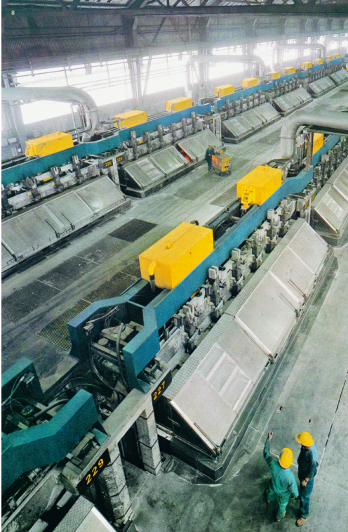
Abb. 30 Einkapselte Elektrolyseöfen in Steg (Alusuisse-Geschäftsbericht 1981, in: SWA, PA 600b C 1).
