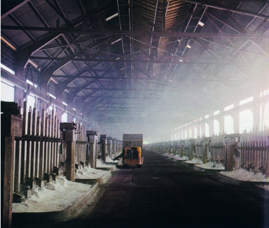
Abb. 29 Elektrolysehalle der Aluminiumhütte Steg (Alusuisse-Geschäftsbericht 1962, in: SWA, PA 600b C 1).
