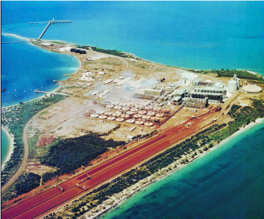
Abb. 9 Luftaufnahme der Aluminafabrik samt Bauxitlager und Hochseehafen (Alusuisse-Broschüre, o. D., in: SWA, PA 600b N 40).
