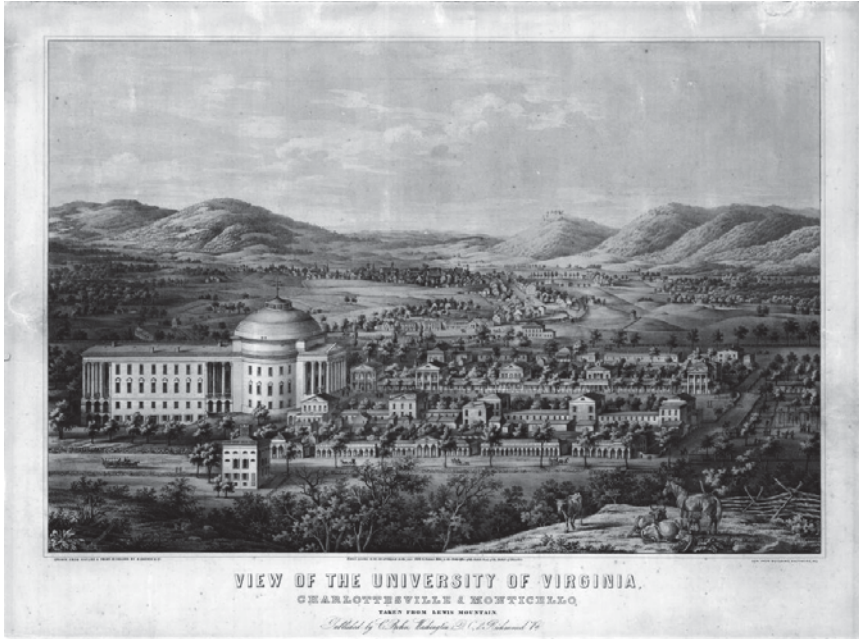
Fig. 9. Virginia University in Charlottesville, designed by Thomas Jefferson (1817). Source: Rückbrod, Konrad: Universität und Kollegium. Baugeschichte und Bautyp. 1977, p. 92.
