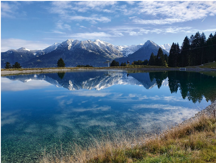
Abb. 4.61 Speichersee Söllereck (A) ein Jahr nach Baufertigstellung. (C. Weiler)
