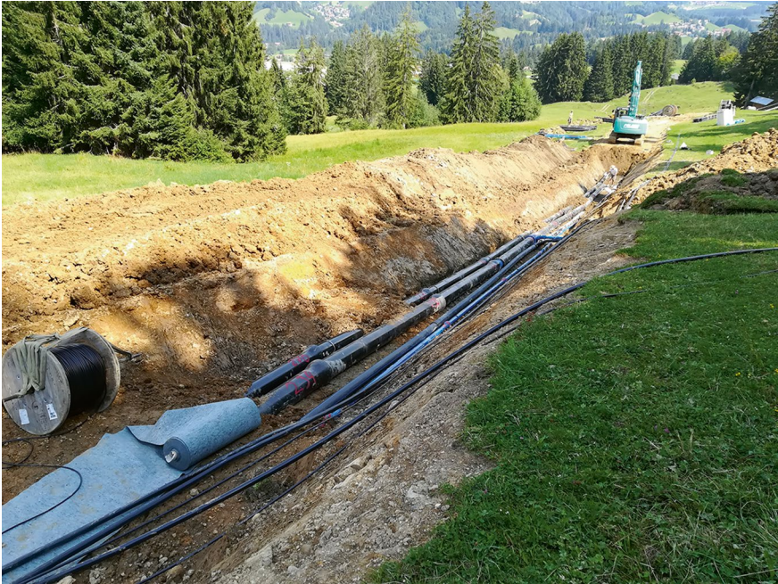
Abb. 5.4 Schneileitungsgraben mit getrennter Lagerung der ausgehobenen Bodenschichten. (C. Weiler)
