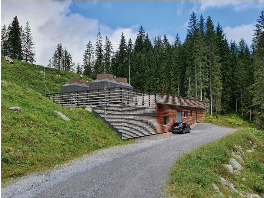
Abb. 3.19 Im Regelfall haben die Pumpstationen, zumeist mit integrierten Kühlturmanlagen, eine Größenordnung, sodass eine „weitgehend unsichtbare“ Ausführung nicht mehr möglich ist. Hier wird dann durch Holzverschalungen und landschaftsangepasste Farbgebung eine bestmögliche Integration in die Umgebung hergestellt. Das Bild zeigt die Pumpstation am Ifen/Kleinwalsertal. (C. Weiler)
