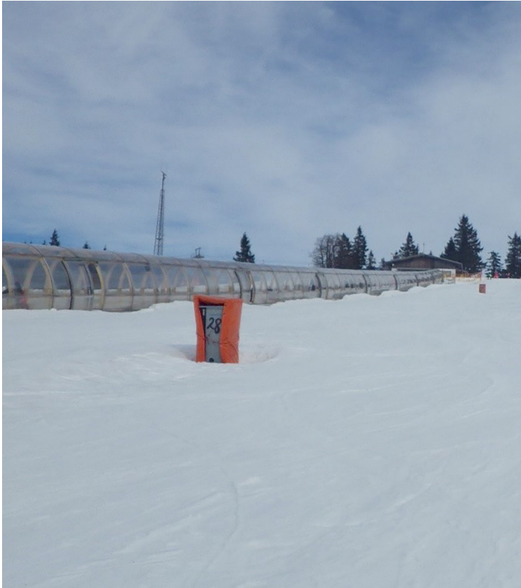
Abb. 3.13 Oberflurhydrant im Winter mit Schutzvorrichtung. (C. Weiler)
