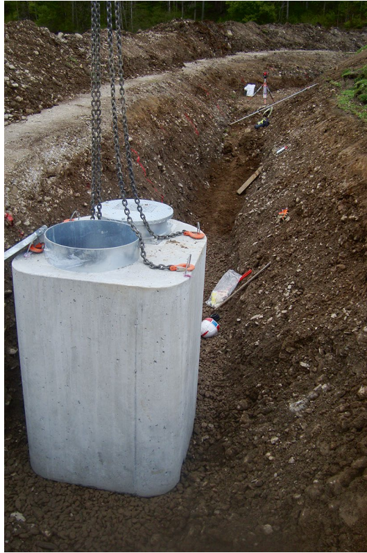
Abb. 3.11 Unterflurschneischacht beim Versetzen im Schneigraben. (C. Weiler)
