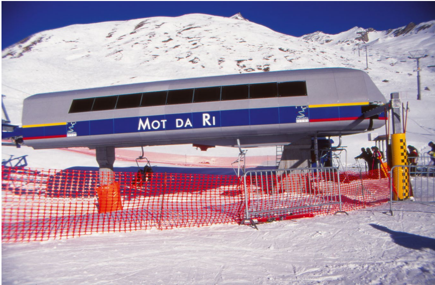
Abb. 4.58 Bei der Bewertung der landschaftsästhetischen Belastung durch Bestandteile der Beschneiungsanlage ist die sonstige technische Infrastruktur zu berücksichtigen. (U. Pröbstl-Haider)
