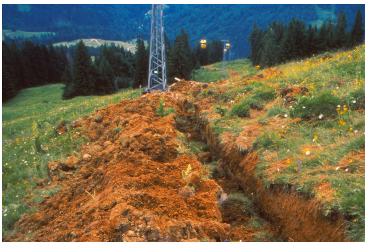
Abb. 3.7 Bau eines Leitungsgrabens (E. Stadler)
