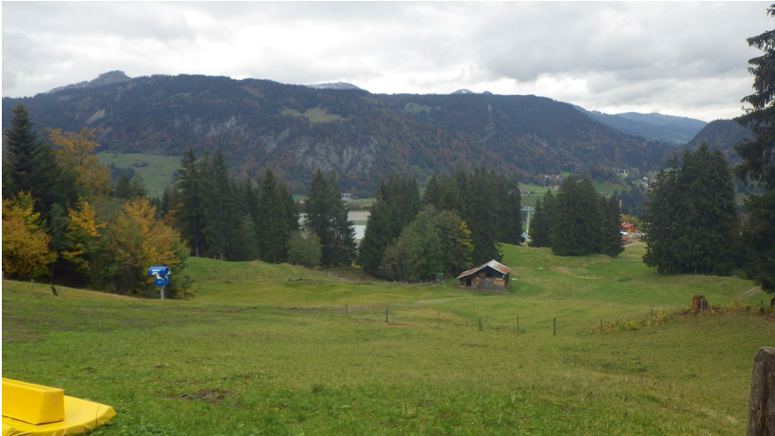
Abb. 5.12 Schonende Bauarbeiten kommen der Erholungsnutzung im Sommer entgegen. Schneileitungsgraben unmittelbar nach der Fertigstellung unter Verwendung von Rasensoden ist kaum mehr erkennbar. (C. Weiler)
