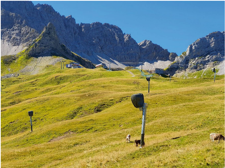
Abb. 3.22 Propeller-Schneeeerzeuger auf Türmen mit Sommerabdeckung. (C. Weiler)
