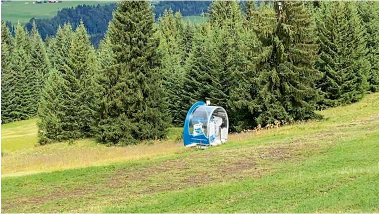
Abb. 5.6 Schneileitungsgraben unmittelbar nach Fertigstellung. Durch die Verwendung von Rasensoden kann ein wirksamer Schutz des Oberbodens vor Wassererosion erreicht und eine naturnahe Regeneration der Pflanzengesellschaft begünstigt werden, (C. Weiler)
