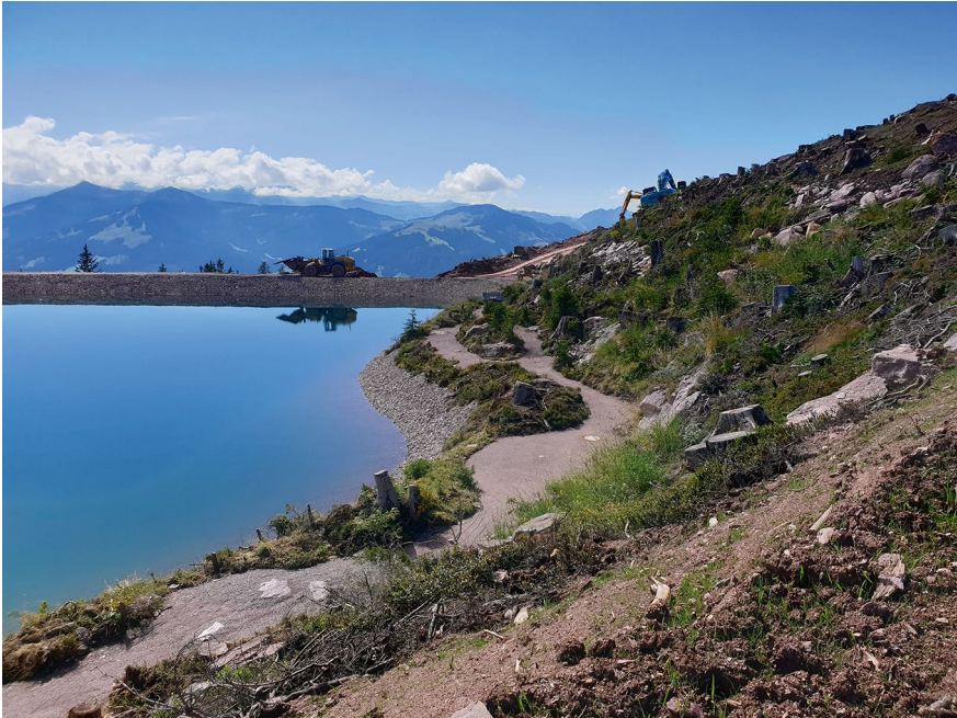
Abb. 3.16 Aufwändige Gestaltung der Dammkrone entlang des Speicherteiches, Teilbereiche noch im Bau. (C. Weiler)
