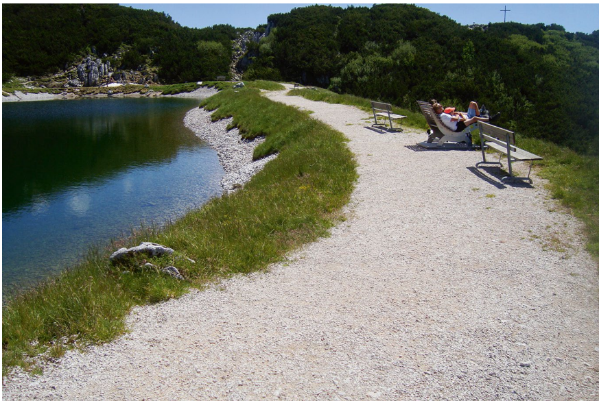
Abb. 5.9 Naturferne Gestaltung der Uferzone am Speichersee verhindert die Besiedelung durch Amphibien und Libellenarten. Idealerweise wird für diese Arten ein eigener Biotopteich angelegt. Die Böschungskrone bietet sich für Erholungsnutzung an. (C. Weiler)
