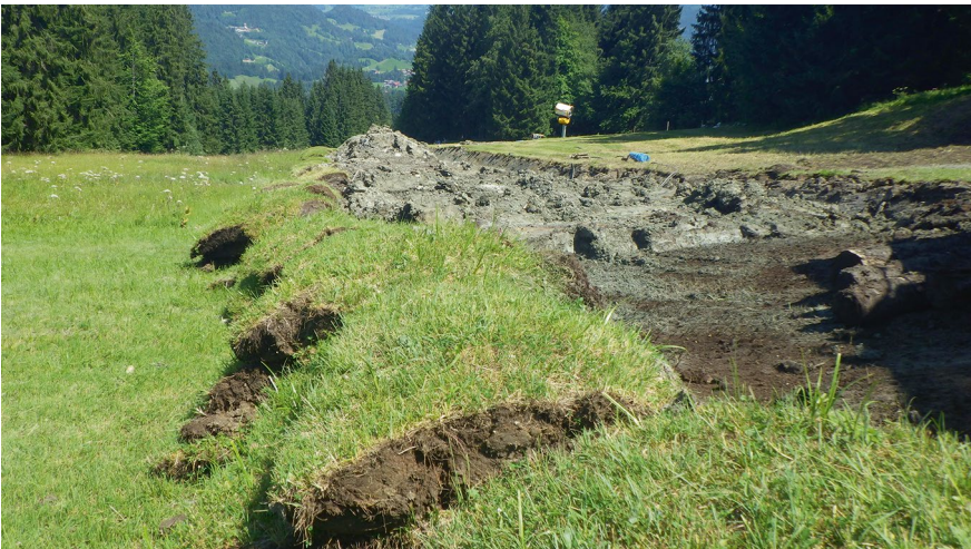
Abb. 5.5 Rohrleitungsgraben mit seitlicher Lagerung von Rasensoden. (C. Weiler)
