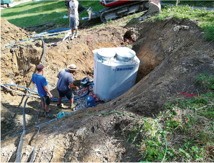
Abb. 5.13 Versetzen eines Schneischachtes. (C. Weiler)
