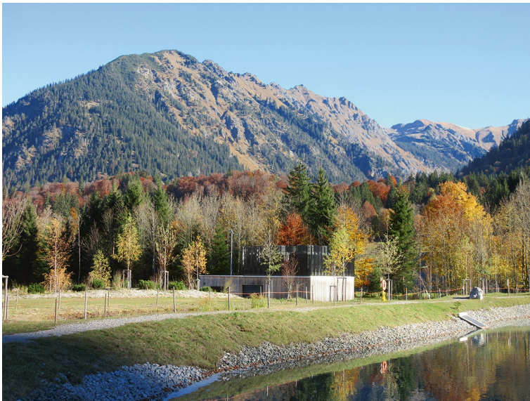
Abb. 5.10 Bündelung von Infrastruktur zugunsten des Landschaftsbildes, Kühlturm am Dach der Pumpstation Riedwald in Oberstdorf. (C. Weiler)
