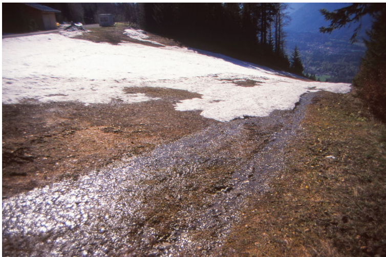
Abb. 4.24 Erhöhte Schmelzwassermenge am Pistenrand mit beginnender Erosion durch unzureichende Wasserausleitung und Störung des Bodens durch den Bau des Leitungsgrabens. (U. Pröbstl-Haider)
