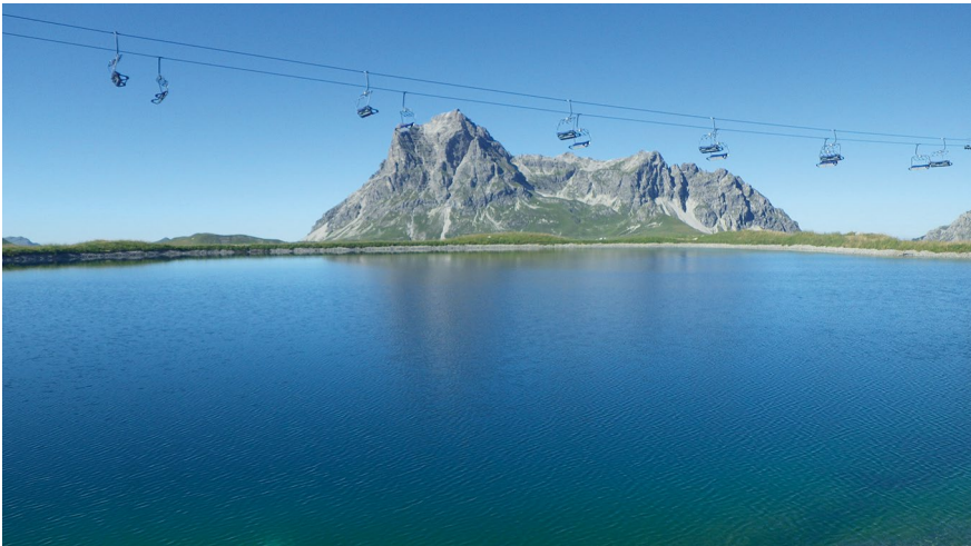
Abb. 4.59 Speichersee Hochalpsee-Warth (A) ein Jahr nach Baufertigstellung. (C. Weiler)
