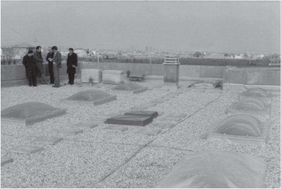
Fig. 20 - La copertura dell'ufficio di San Mauro Pascoli (FC), con struttura in calcestruzzo armato. In evidenza i lucernari a cupola e piatti (AM, fondo IN.CO. S.p.A. e Silvano Zorzi, DOI: https://doi.org/10.24443/usi-arc-bib_FINC.48505 , ID immagine: 48505)
