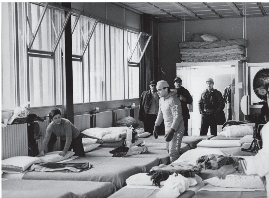
Fig. 3,4 - L'ufficio postale di Sant'Angelo dei Lombardi (AV) uno dei pochi edifici rimasti in piedi dopo il terremoto del 1980 e utilizzato come rifugio (Archivio M. Ruffilli)
