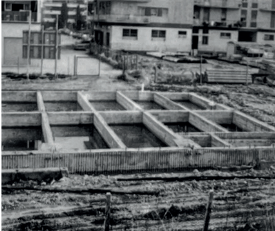
Figg. 15,16 - Foto di cantiere. Le fondazioni gettate in opera sono la base di appoggio per le strutture prefabbricate in cemento o acciaio; movimentazione di un pannello (Ruffilli, 1979)
