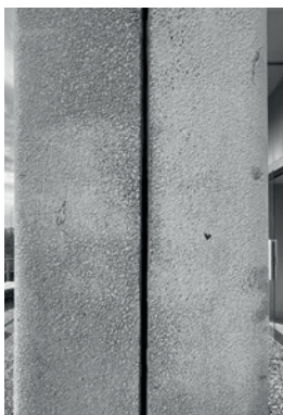
Fig. 8 - Elementi angolari per il rivestimento dei pilastri stoccati in stabilimento (AM, fondo IN.CO. S.p.A. e Silvano Zorzi, DOI: https://doi.org/10.24443/usi-arc-bib_FINC.48527 , ID immagine: 48527)
