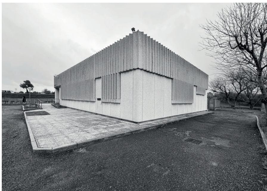
Figg. 9,10 - Ufficio di Montalto di Castro (VT), 2025
