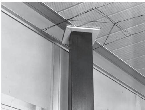
Fig. 12,13 - Dettagli del raccordo del pilastro con il divisorio e il controsoffitto (ASF, b. 147/206-207)
