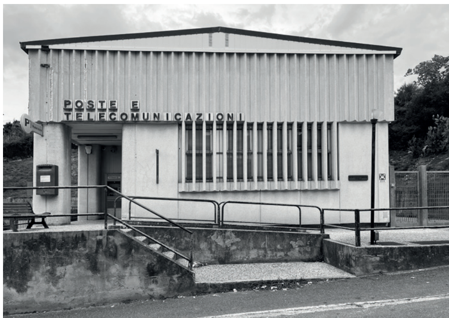
Fig. 5 - Ufficio di San Calogero (VV), 2025. Geometria e caratteri della copertura sono stati profondamente alterati dagli interventi di manutenzione realizzati negli anni
