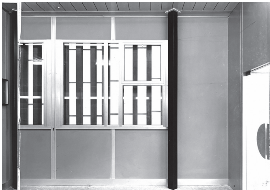
Fig. 10 - Vista interna. Si nota il pilastro, ruotato di 45° rispetto alla griglia planimetrica secondo cui sono disposti gli altri elementi costruttivi (ASF, b. 147/206-207)
