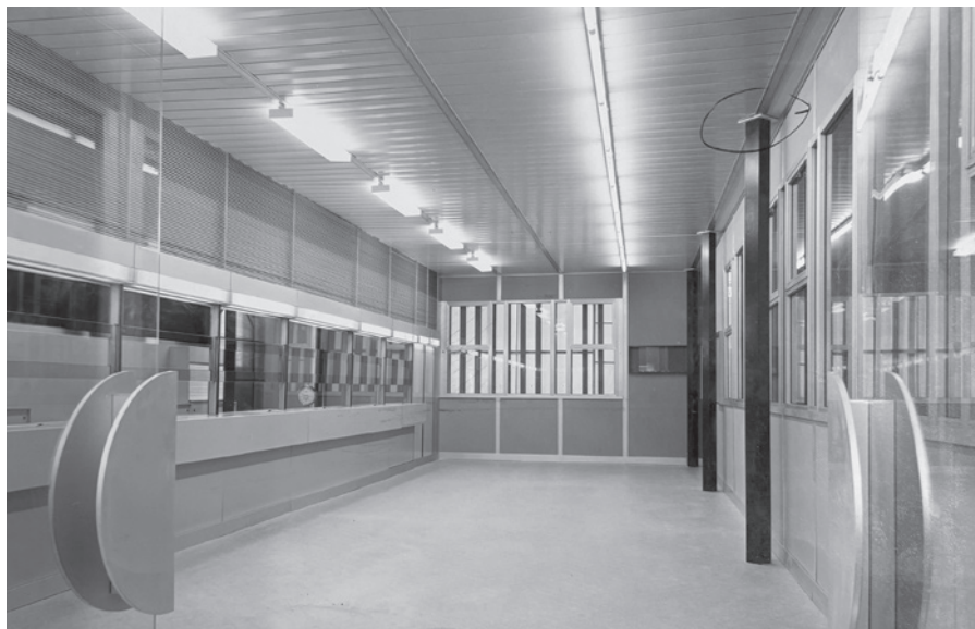
Fig. 9 - Un interno del modello al vero con struttura in acciaio. In evidenza i pilastri a sezione quadrata (ASF, b. 147/206-207)
