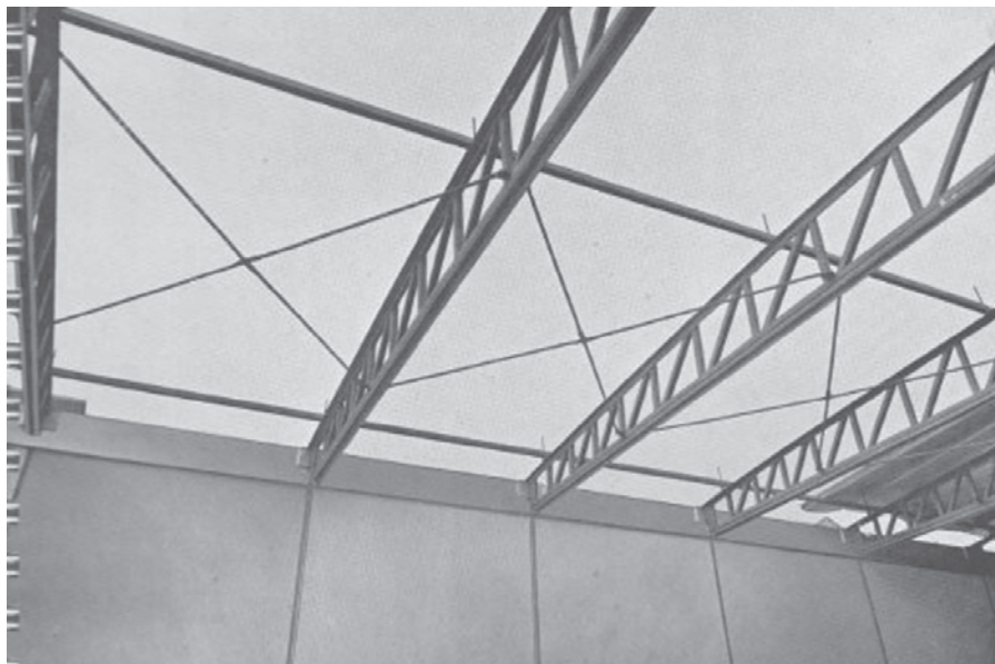
Fig. 5 - Sistema di prefabbricazione integrale Ipi. In evidenza le capriate di copertura, simili agli elementi impiegati, dalla stessa Ipi system nella costruzione del prototipo di ufficio postale (Ipi, Fascicolo)
