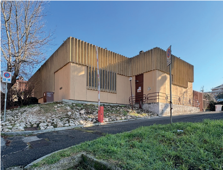
Figg. 32,33 - Ufficio di Rocca Priora (RM), 2025
