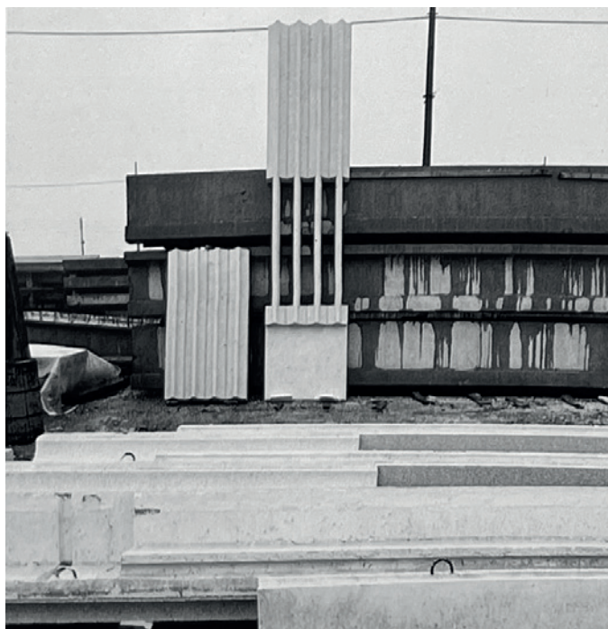
Fig. 34 - I pannelli pronti per il montaggio (Domus, 594, 1979)
