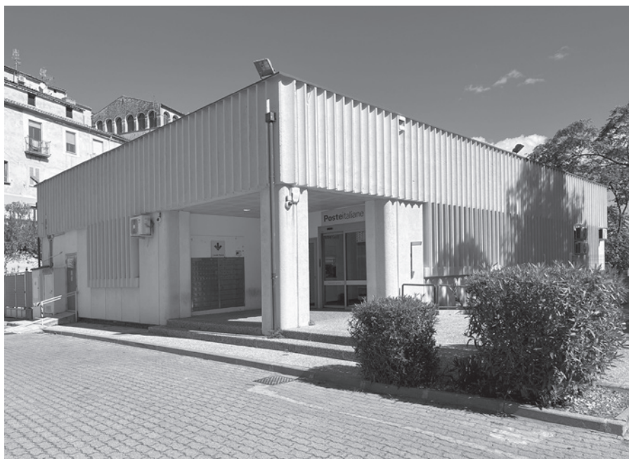
Figg. 7,8 - Ufficio di Cassano allo Ionio (CS), 1978 (ASF, b. 46) e l'edificio oggi
