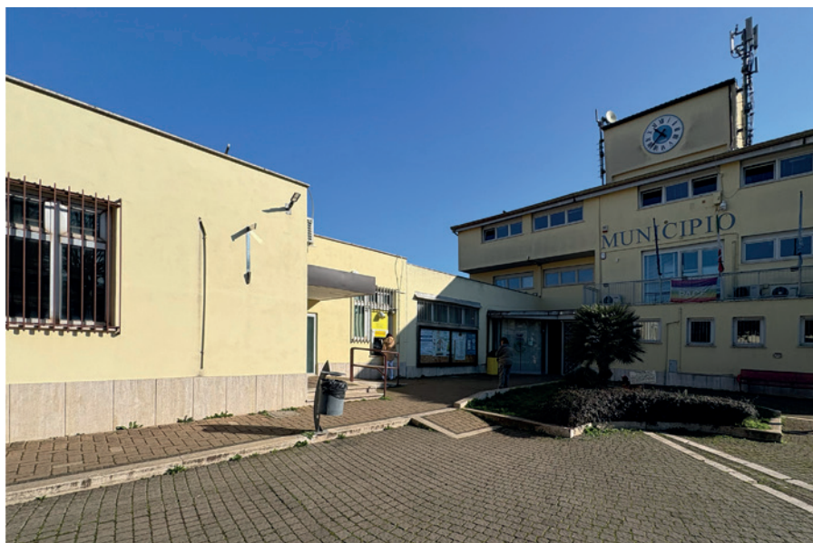
Figg. 36,37 - Ufficio di San Cesareo (RM), 2025; l'edificio è stato completamente rivestito con intonaco e collegato al Municipio
