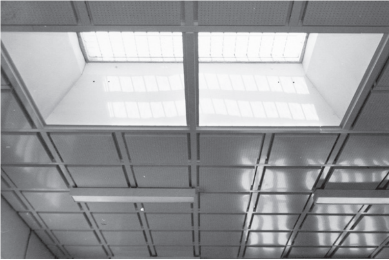
Fig. 12 - Vista del controsoffitto e di uno dei lucernari a cupola (AM, fondo IN.CO. S.p.A. e Silvano Zorzi, DOI: https://doi.org/10.24443/usi-arc-bib_FINC.48495 , ID immagine: 48495)
