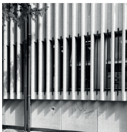
Figg. 6,7 - Ufficio di Gioiosa Ionica (RC) 2025; si nota l'integrazione di discendenti supplementari, affiancati a quelli originari.
