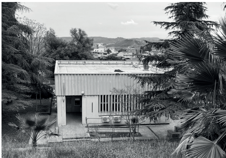
Figg. 13,14 - Gli uffici postali a Rende (CS) e Rocca di Neto (KR), realizzati da De Lieto Costruzioni Generali con CMB (2025)
