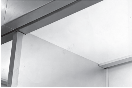
Fig. 11 - Dettaglio del raccordo tra divisori e controsoffitto (ASF, b. 147/206-207)
