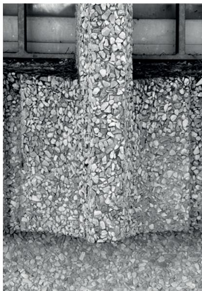
Fig. 24,25 - Ufficio postale di Atina (FR) 2025, dettaglio di un pannello prefabbricato. Ufficio postale di Civita Castellana (VT) 2025, Dettaglio dell'attacco a terra dei pannelli prefabbricati
