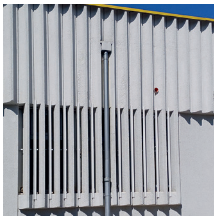
Fig. 13,14 - L'edificio di Aciri è stato ristrutturato nel 2023; i pannelli sono stati tinteggiati di bianco, sono stati inseriti la scossalina a protezione della testa degli elementi, nuovi discendenti e sostituiti gli infissi
