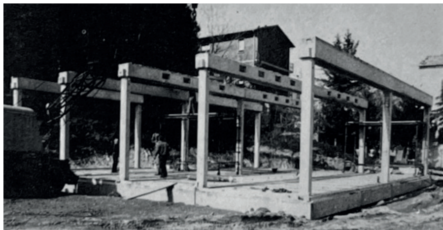
Fig. 37 - Foto di cantiere in fase di ultimazione della struttura (Ruffilli 1979)
