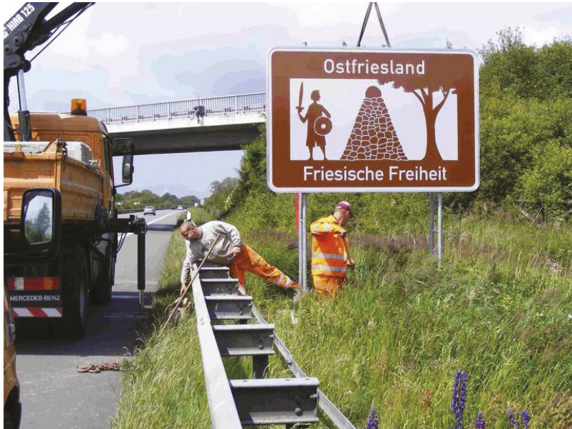
Aufbau des Autobahnschildes
