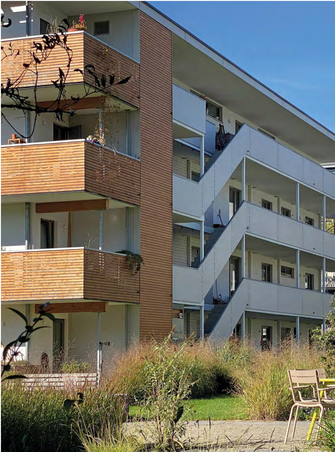
Abb. 34: Alte Weberei Tübingen. Innenhof mit mehreren Wohnprojekten (eigene Aufnahme, Okt. 2021)
