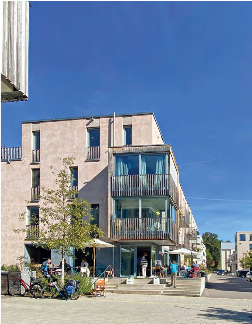
Abb. 31: Alte Weberei Tübingen. Egeriplatz, Wohnprojekt mit Gastronomie im Erdgeschoss (links) und historisches Gebäude mit Gewerbenutzungen (eigene Aufnahme, Okt. 2021)
