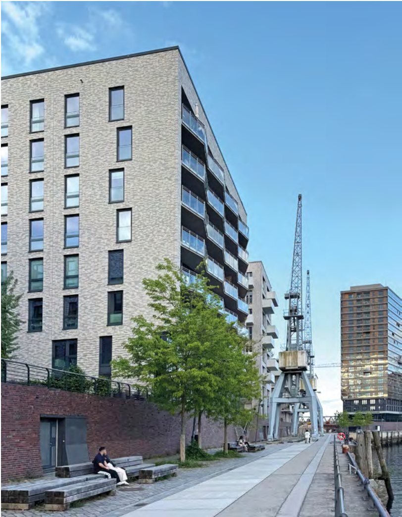
Abb. 83: Quartier Baakenhafen in der HafenCity Hamburg, Wohnprojekt im individuellen Eigentum, Fassade zum Innenhof und zu der öffentlichen Promenade (eigene Aufnahme, Mai 2025)
