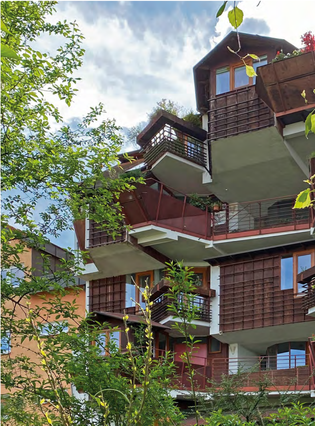
Abb. 15: Loretto-Areal in der Tübinger Südstadt. Fassade eines Wohnprojektes im Innenhof (eigene Aufnahme, Mai 2022)
