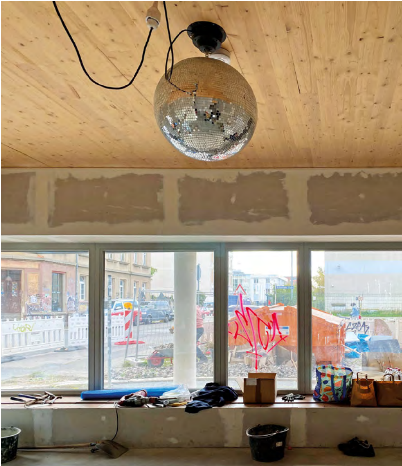
Abb. 60: Leipzig-Plagwitz, Wohnprojekt Klinge 10 im Modell des Mietshäuser Syndikats, Gemeinschaftsraum im Erdgeschoss kurz vor Baufertigstellung (eigene Aufnahme, Sept. 2023)
