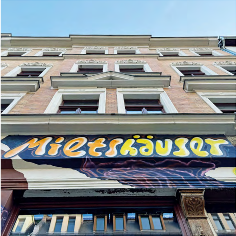
Abb. 44: Leipzig Altlindenau, Georg-Schwarz-Straße, Wohnprojekt Spieszgesellen im Modell des Mietshäuser Syndikats, Fassade mit der Aufschrift ‚Mietshäuser‘ (eigene Aufnahme, Aug. 2024)
