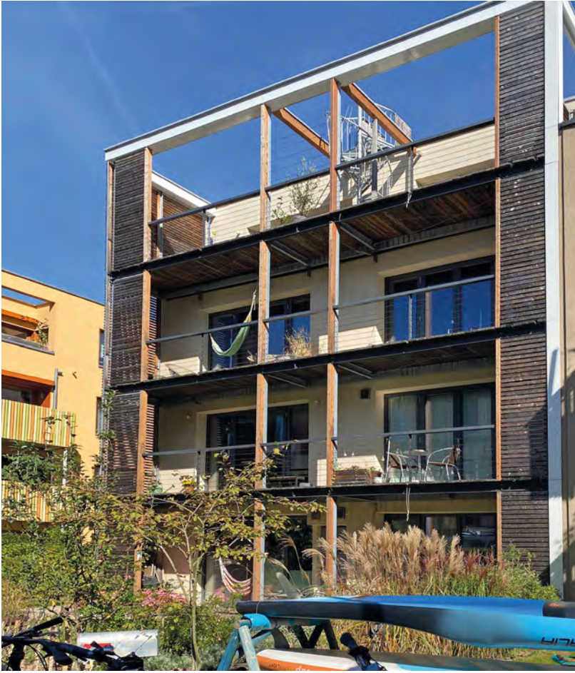
Abb. 32: Alte Weberei Tübingen. Fassade eines Wohnprojektes mit Balkonen (eigene Aufnahme, Okt. 2021)
