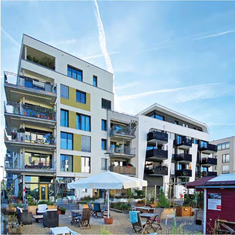
Abb. 36: Alter Güterbahnhof Tübingen. Öffentlicher Raum am Max-Löwenstein-Weg, Wohnprojekt auf der linken Seite und Gebäude des Trägers Aurelis auf der rechten Seite (eigene Aufnahme, Okt. 2021)
