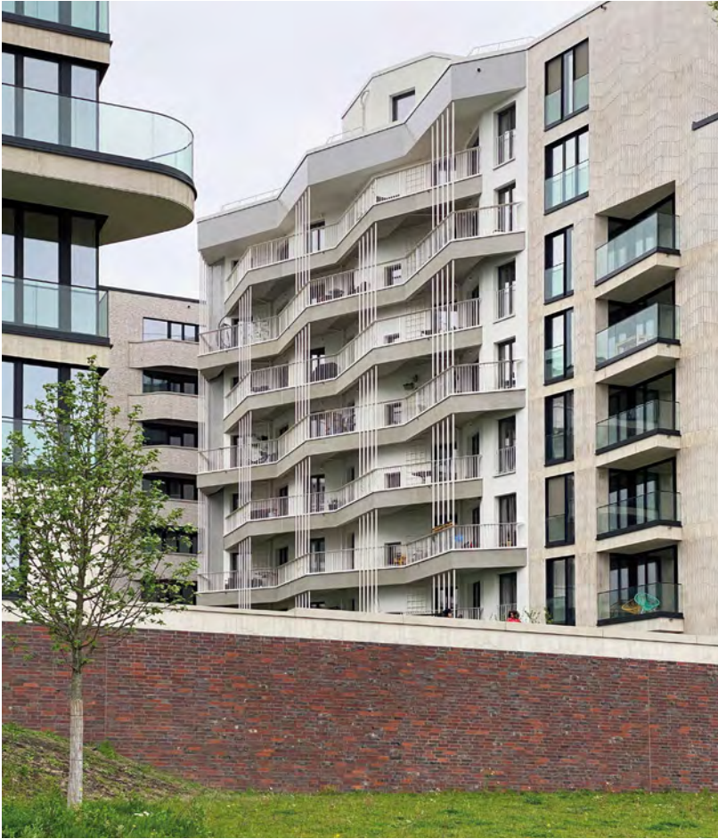
Abb. 84: Quartier Baakenhafen in der HafenCity Hamburg, Wohnprojekt im individuellen Eigentum (mittig im Bild), Fassade zum Innenhof (eigene Aufnahme, April 2024)
