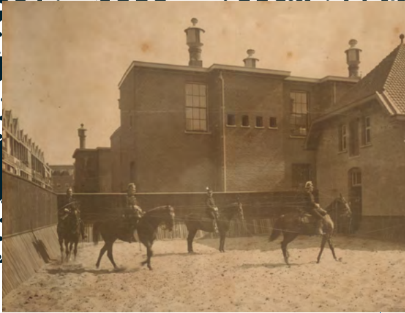
3 Rijlessen in de buitenmanege aan de Duivenvoordestraat te Rotterdam, circa 1900.
