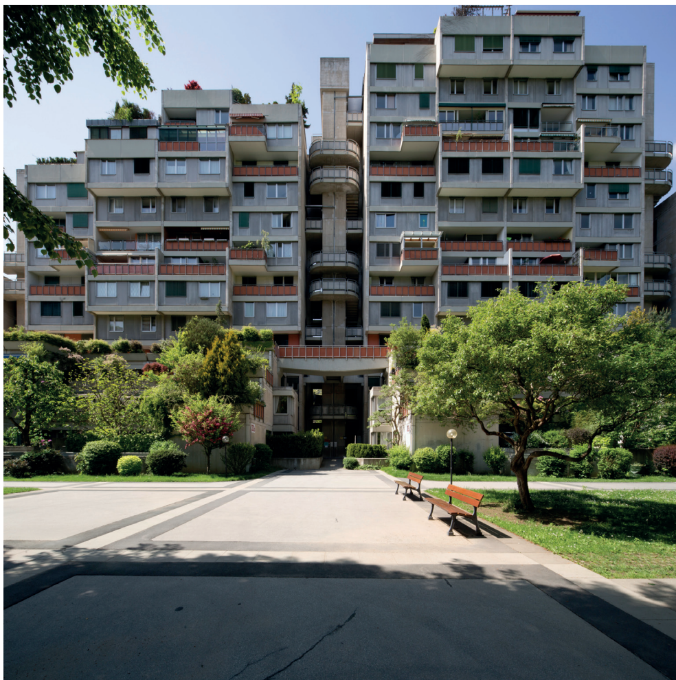
Abb. 7: Terrassenhaussiedlung Graz, St. Peter (Bundesdenkmalamt, Aufn. B. Neubauer-Pregl)
