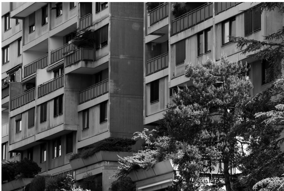
Abb. 8: Terrassenhaussiedlung Graz, St. Peter (Bundesdenkmalamt, Aufn. B. Neubauer-Pregl)
