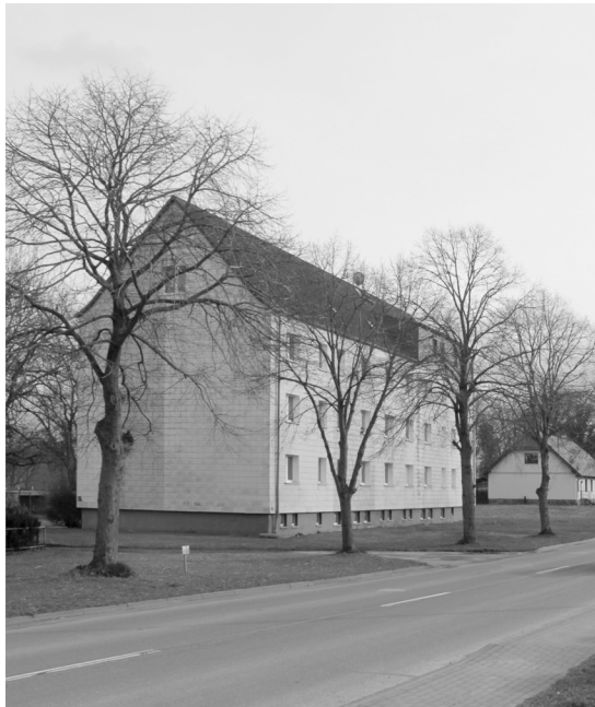
Abbildung 10: DDR-Neubau (dreigeschossig mit ausgebautem Satteldach) an der Dorfstraße, Mecklenburg-Vorpommern. Beispielfoto.
