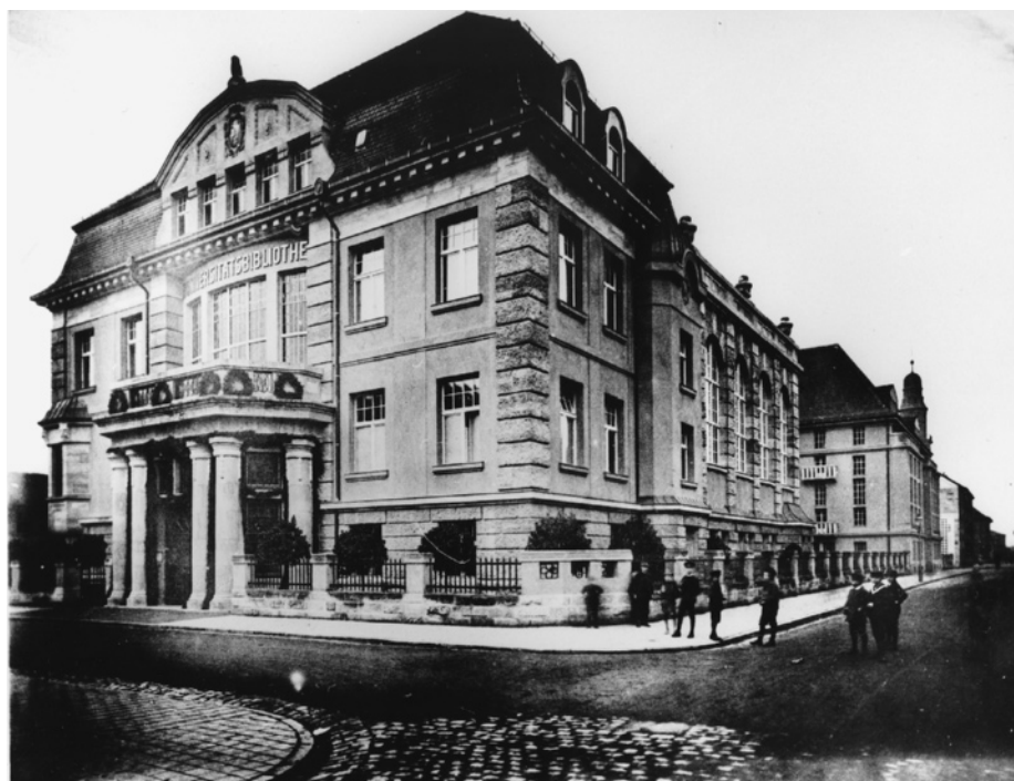
Nordostfassade, Aufnahme vor dem Umbau 1962.
