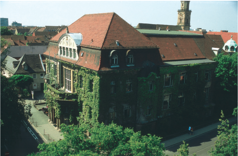
Blick vom Nordosten auf den Altbau.
