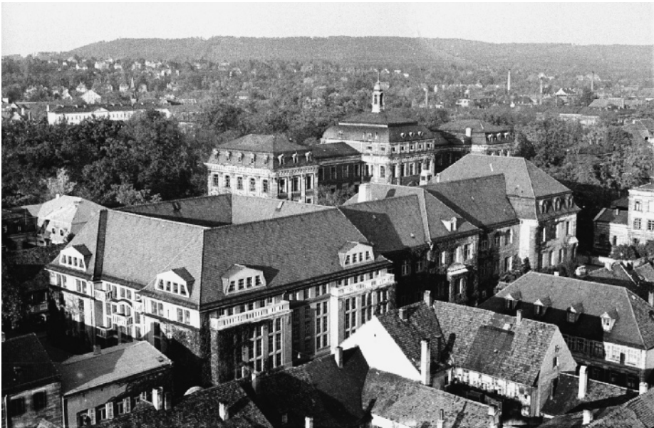
Luftbild: Blick von Südwesten auf Universitätsbibliothek und Kollegienhaus.
