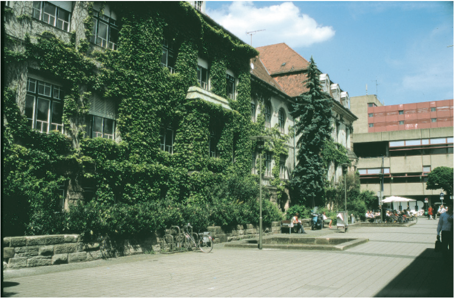
Blick von Südwesten auf den Altbau und den Neubau der Universitätsbibliothek.
