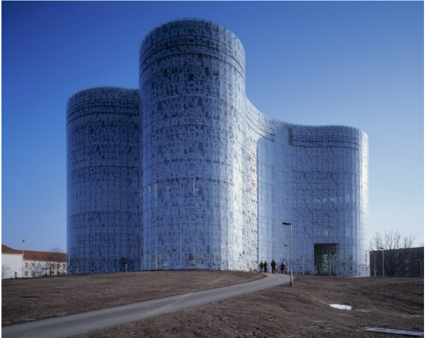
Abb. 13: Informations-, Kommunikations- und Medienzentrum (IKMZ) der Technischen Universität in Cottbus
