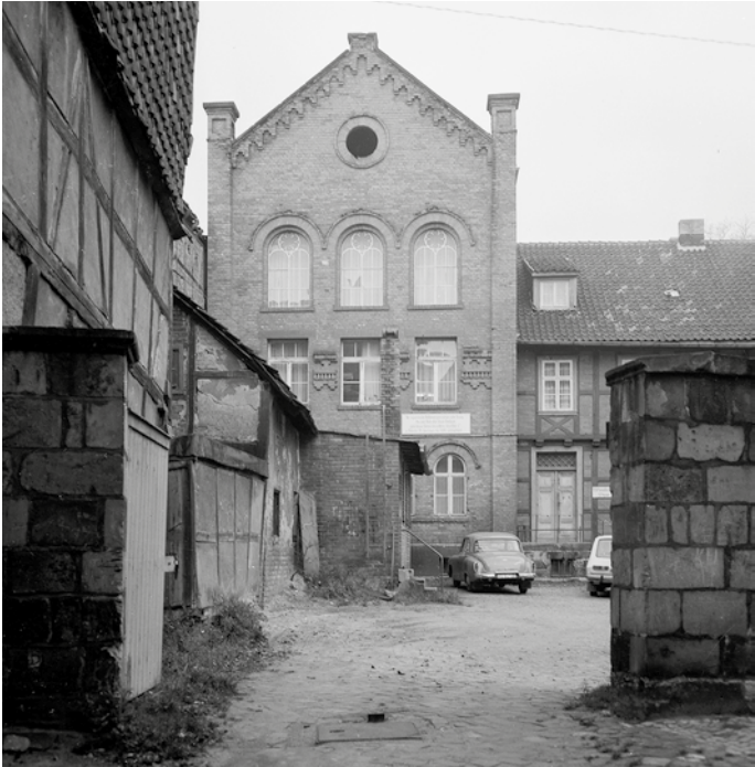
Abb. 3: Die ehemalige Klaussynagoge im Rosenwinkel 18 zur Zeit ihrer Nutzung durch den VEB Pinselfertigung Halberstadt, nach 1979. © Photo Studio Mahlke, Halberstadt.
