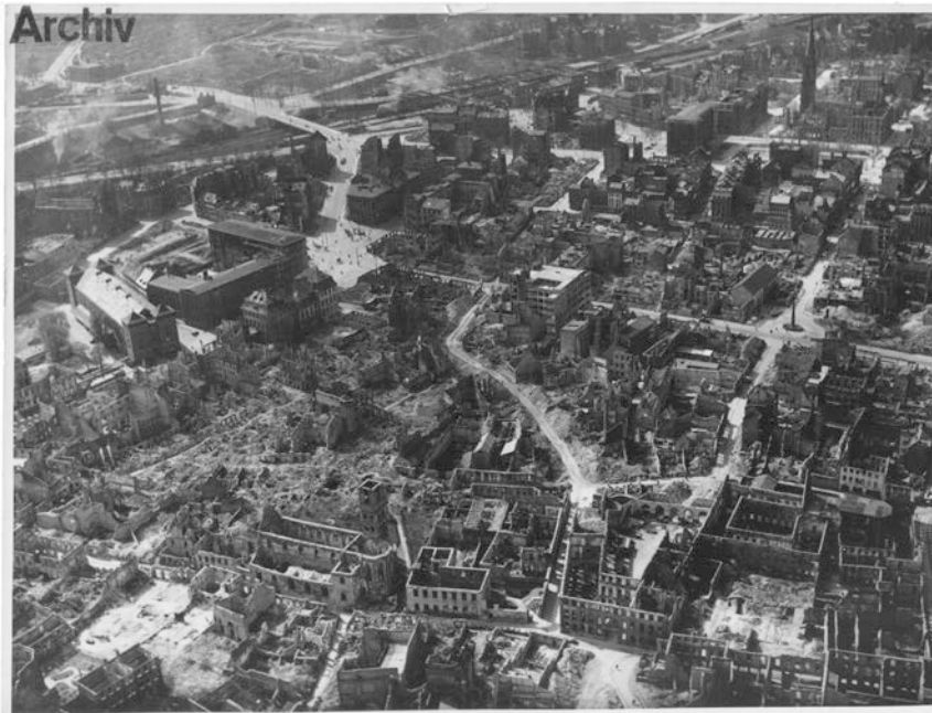
Abb. 1: Luftbild der vom Krieg zerstörten Mainzer Innenstadt (1947). Am linken Bildrand ist in der Mitte das Proviandmagazin zu sehen. © Hanns Tschira, Tschiraphot Wiesbaden.
